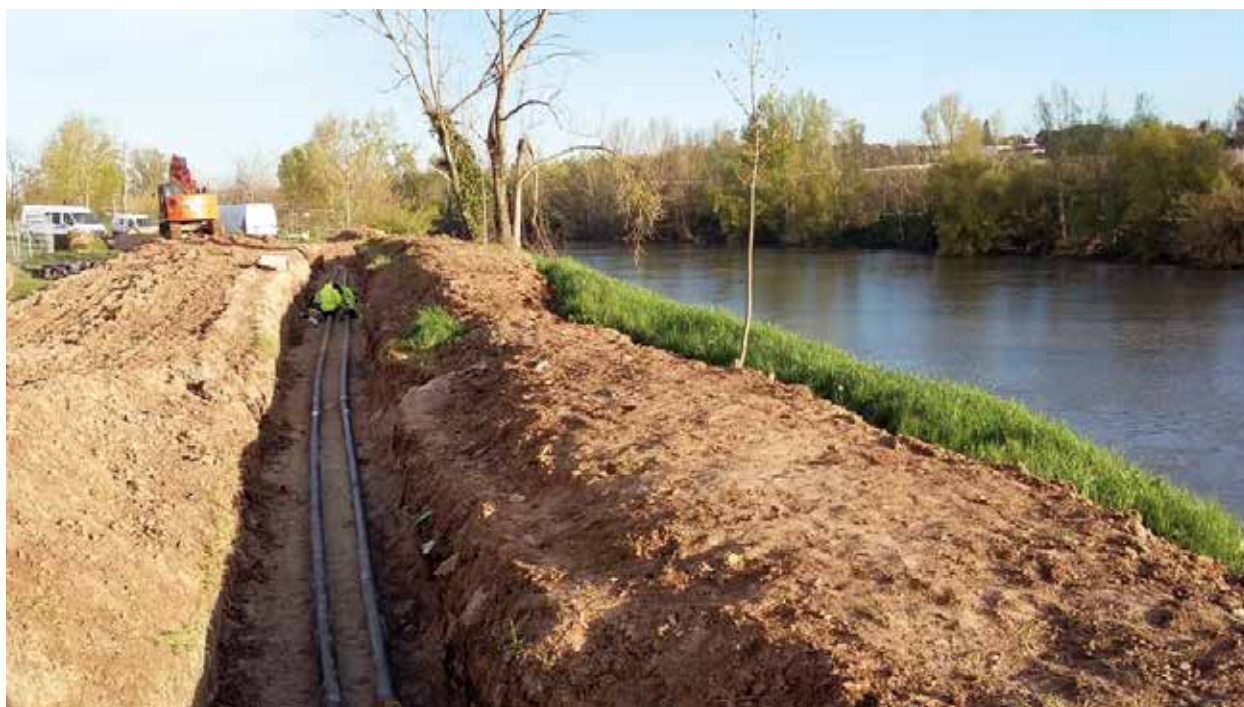
Rénovation antenne des Abattoirs
