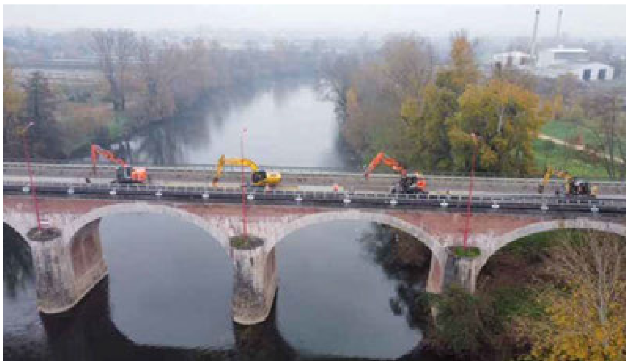
Canalisations du réseau accrochées au Pont de l'Avenir à Montauban.
