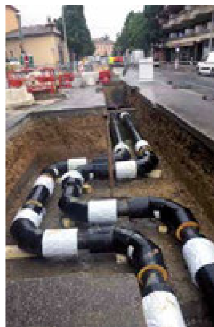
Extension du réseau de chaleur rue Léon Cladel
