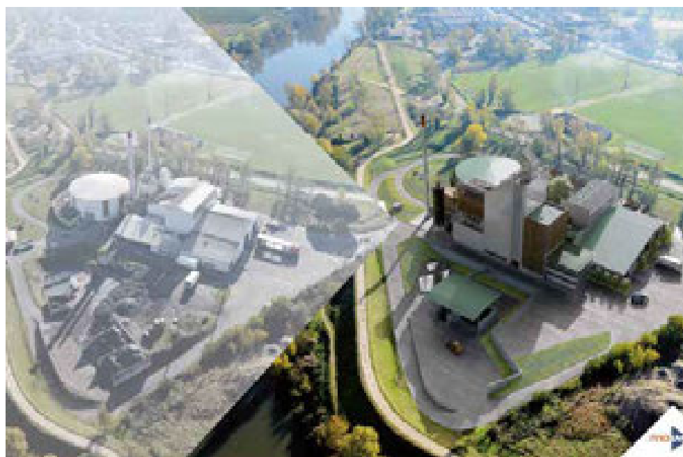
Unité de Valorisation Énergétique : Avant / Après.
