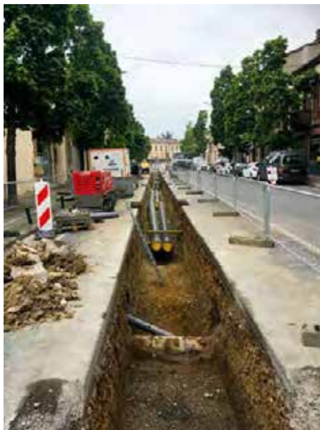
Travaux de raccordement du réseau de chaleur.
