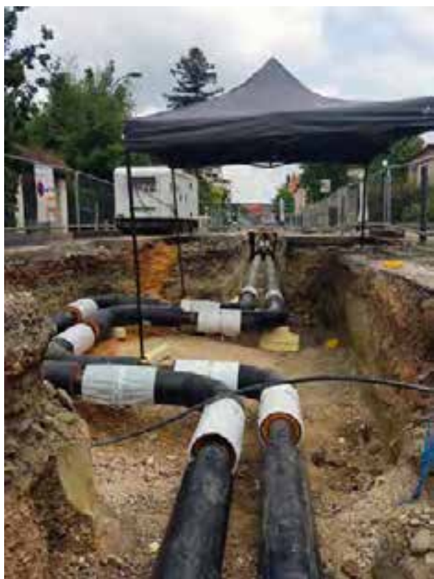
Travaux de raccordement du réseau de chaleur.
