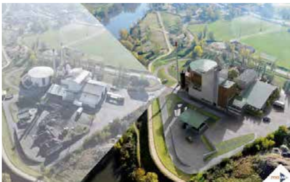
Unité de Valorisation Énergétique : Avant / Après.
